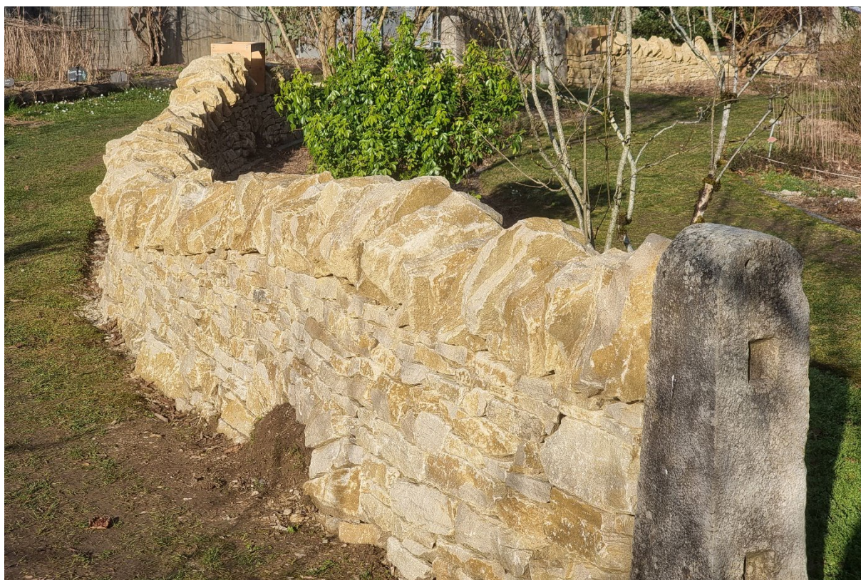
Etat du nouveau mur en pierres sèches lors des travaux, 4 mars 2026. Photo Blaise Mulhauser
