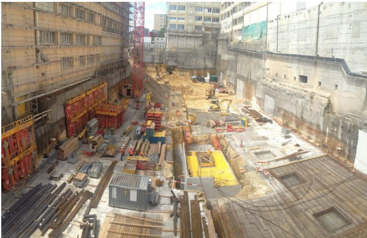
Chantier de construction du pôle muséal, avec vue sur l'étage -4 où se trouveront une grande partie des locaux de conservation des collections de la Ville (23 juin 2021). Photo Blaise Mulhauser
